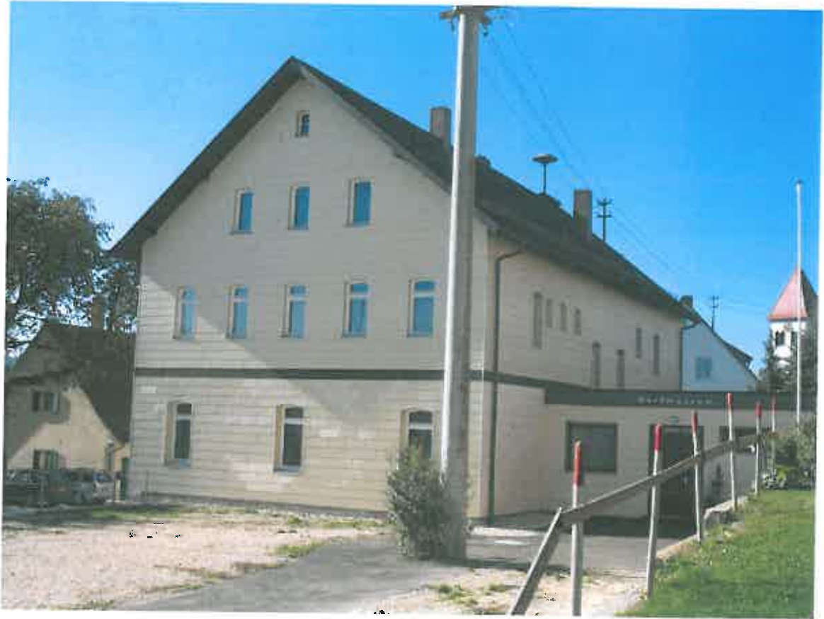
Dorfplatz Markbronn vor der Sanierung
